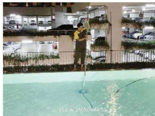
ช่างสูบน้ำ ล้างตะไคร่สระว่ายน้ำ
