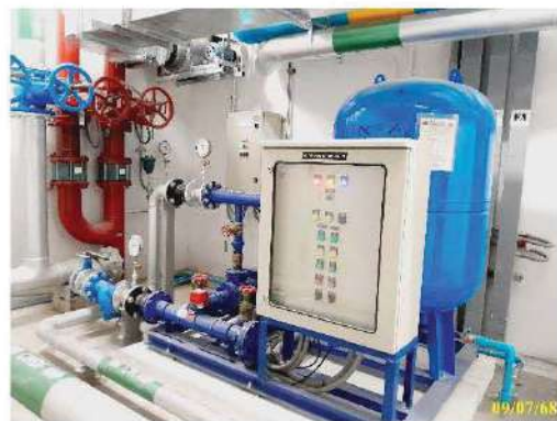
ถังเก็บน้ำ พร้อมเครื่องปั้มน้ำชั้นดาดฟ้า
