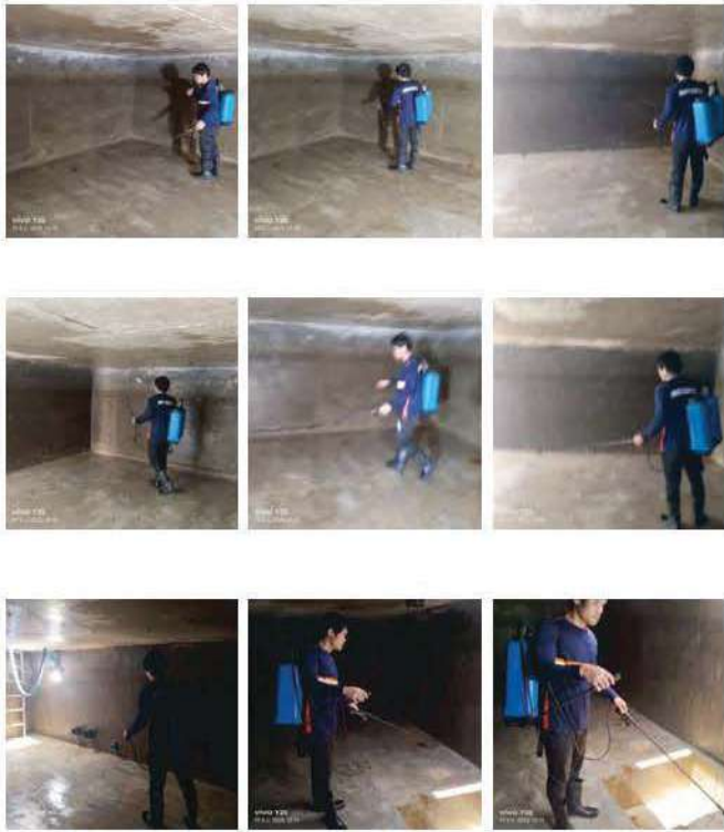
นิติบุคคลอาคารชุด แอสปาย รัตนวิเบศร์-เวสต์คันทัน งานล้างทำความสะอาด แท้งค์เก็บน้ำบนดาดฟ้าที่ 1 ซ้ายมือ
