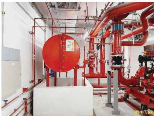
ถังเก็บน้ำ พร้อมเครื่องปั้มน้ำชั้นดาดฟ้า
