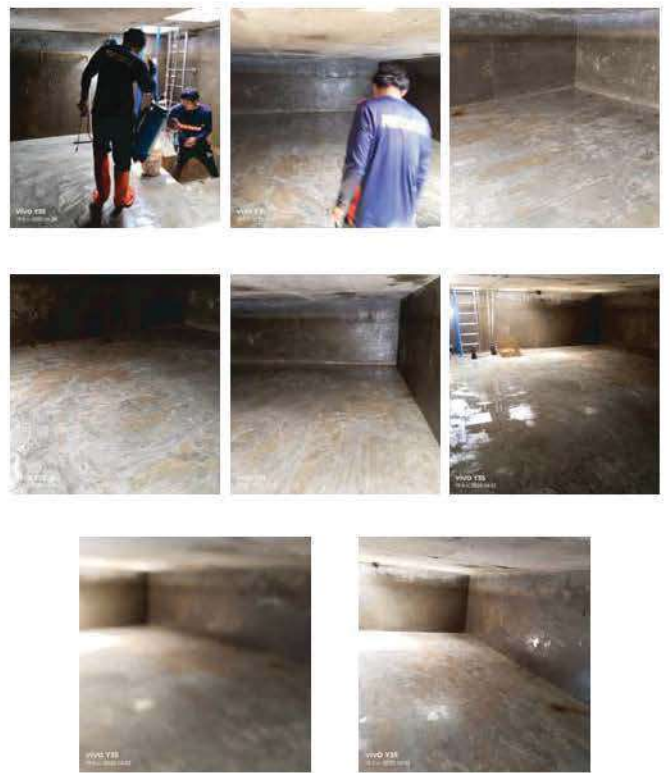
นิติบุคคลอาคารชุด แอสปาย รัตนวิเบศร์-เวสต์คันทัน งานล้างทำความสะอาด แท้งค์เก็บน้ำบนดาดฟ้าที่ 2 ขวามือ
