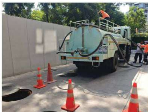
สูบลูกกรองระบบบำบัดน้ำเสีย
